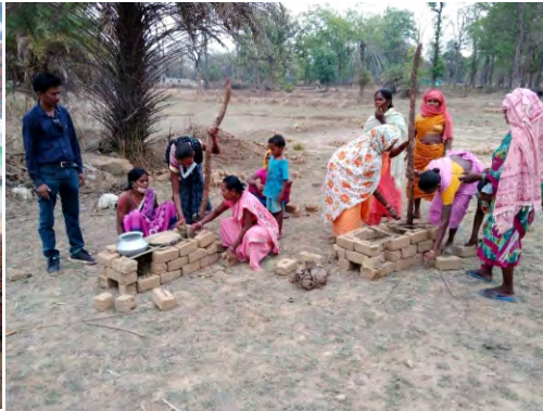
धुआं रहित चूल्हा का निर्माण - डूमरिया-बैकुंठपुर, कन्हार-नारायणपुर
